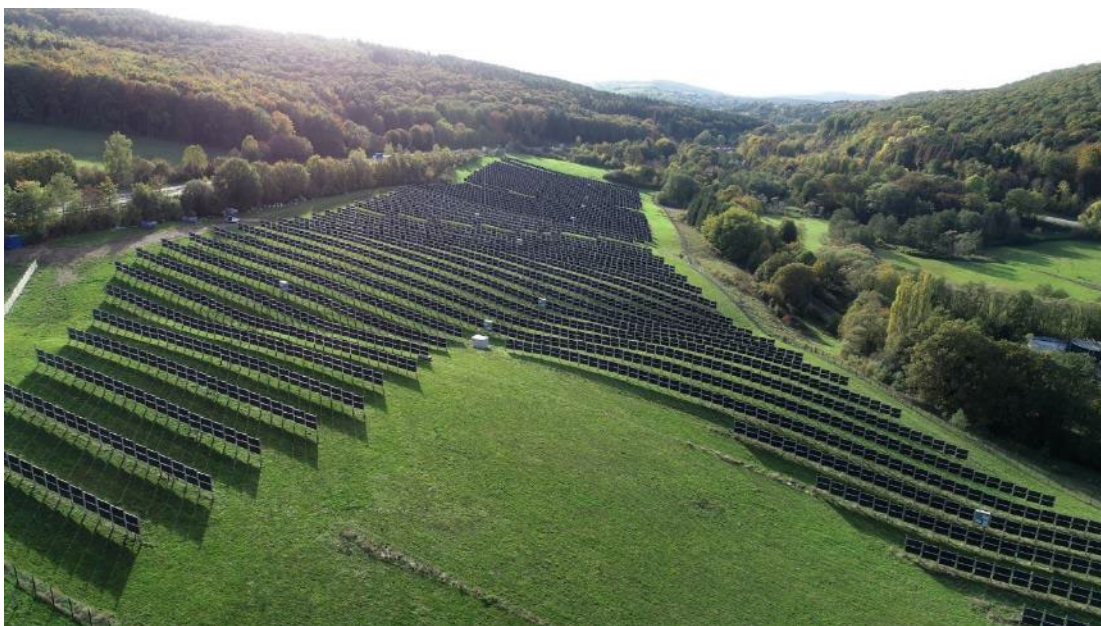
Fotografia 9 Panele w układzie wschód zachód, ustawiane w pionie (źródło: https://www.next2sun.de dostęp z dnia 29.05.2020 r.)
