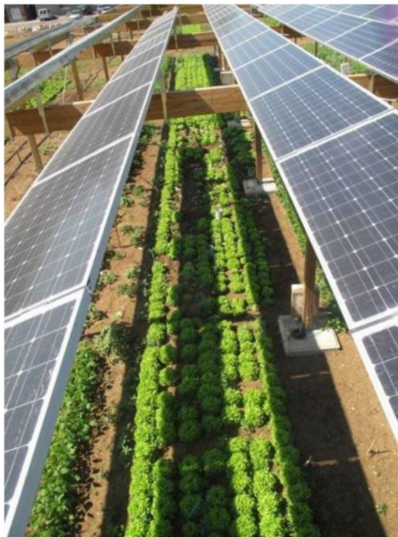
Fotografia 8 Przykład zainstalowanej elektrowni fotowoltaicznej na gruncie, który jest nadal użytkowany rolniczo
