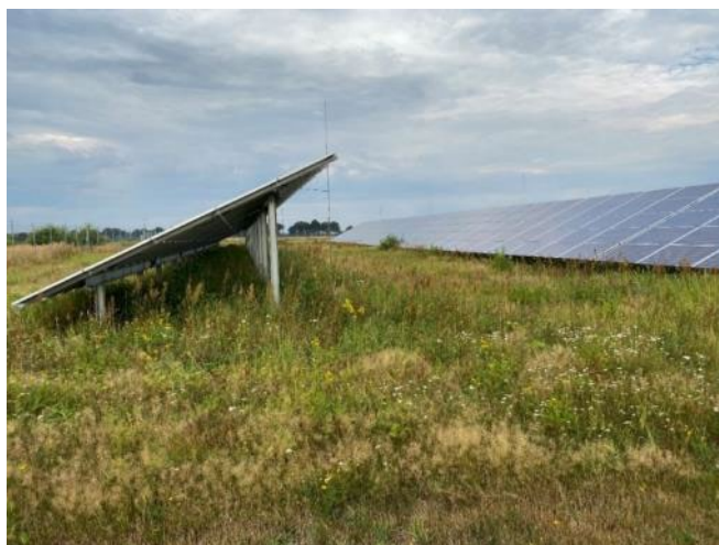
Fotografia 15 Roślinność na terenie istniejącej PV
