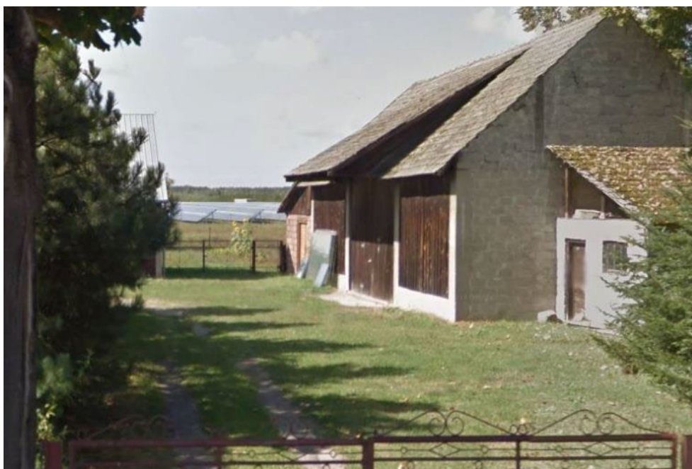
Fotografia 12 Widok w stronę przykładowej instalacji z odległości około 140 metrów
